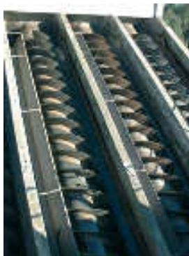
Photo: IBW, vis d'Archimède – STEP de Tubize,
