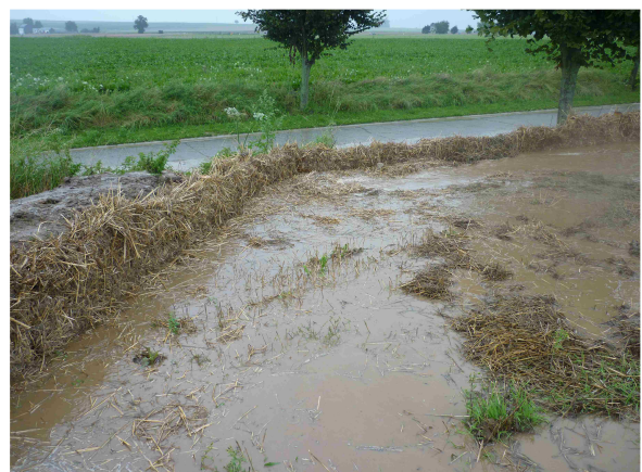
Photo 2 : Ralentissement du ruissellement par une fascine à paille
