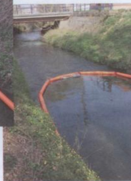
Barrage sur Henri Fontaine à Orp-Le-Petit
