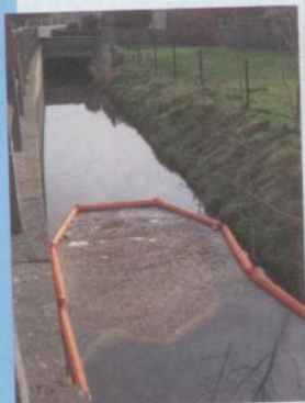
Barrage sur la petite Gette à Jauche
