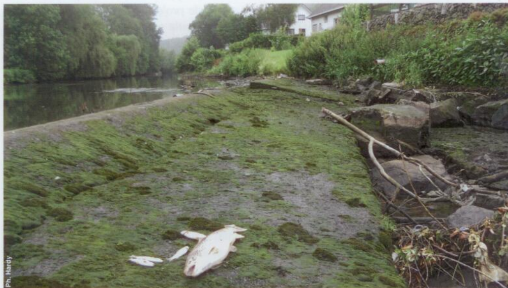
Ph. Hardy L'assèchement de la partie court-circuitée d'une rivière : un des risques hydroécologiques liés à l'exploitation d'une centrale hydroélectrique. Ici, au niveau du barrage de Hauster sur la Vesdre en juin 2011.
