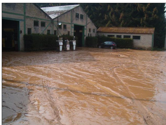
Figure 2 : nappe de boue sur le parking d'une société de transports en commun à Chaumont-Gistoux (photo : Greenotec ASBL, 06/05/2006)
